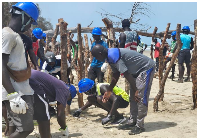
Photo 7 : Mobilisation communautaire pour la réalisation des épis Maltais
