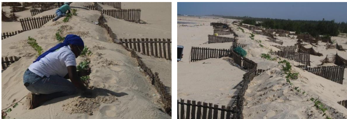
Photo 2 : Casiers pleins et végétalisés pour fixer le sable
