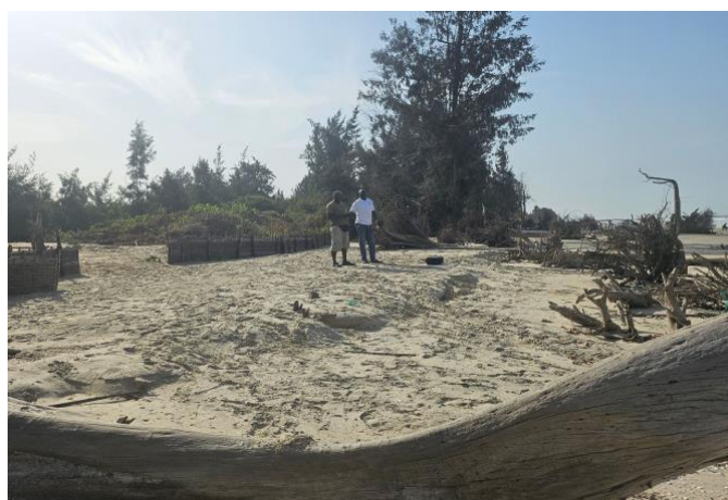
Photo 4 : Accumulation de sable suite à l'installation des épis Maltais Savard
