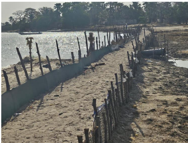
Photo 9 : Digue de Niomoune en phase de stabilisation de la crête.
