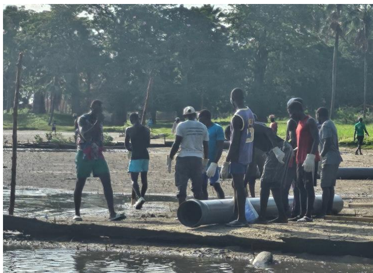
Photo 8 : Travaux communautaires pour la réalisation de la digue de Niomoune
