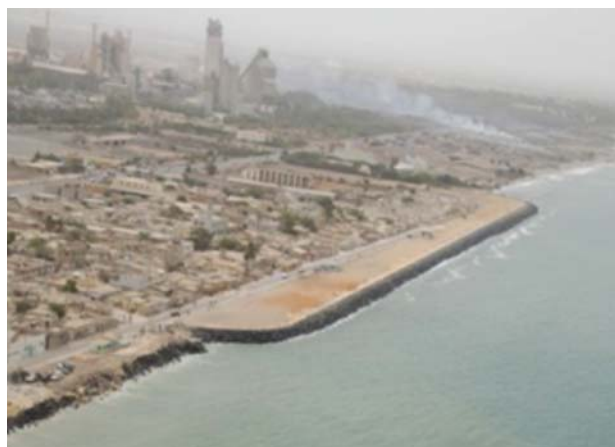
Photo 22 : Enrochements à Bargny (2)
