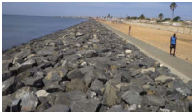
Photo 21 : Enrochements à Bargny (1)
