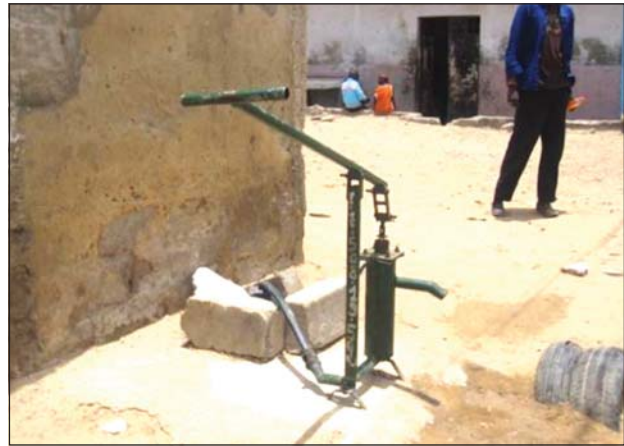
Photo 1 : Mini-forage équipé de PJ installée dans la rue (DGRPE, 2012)
