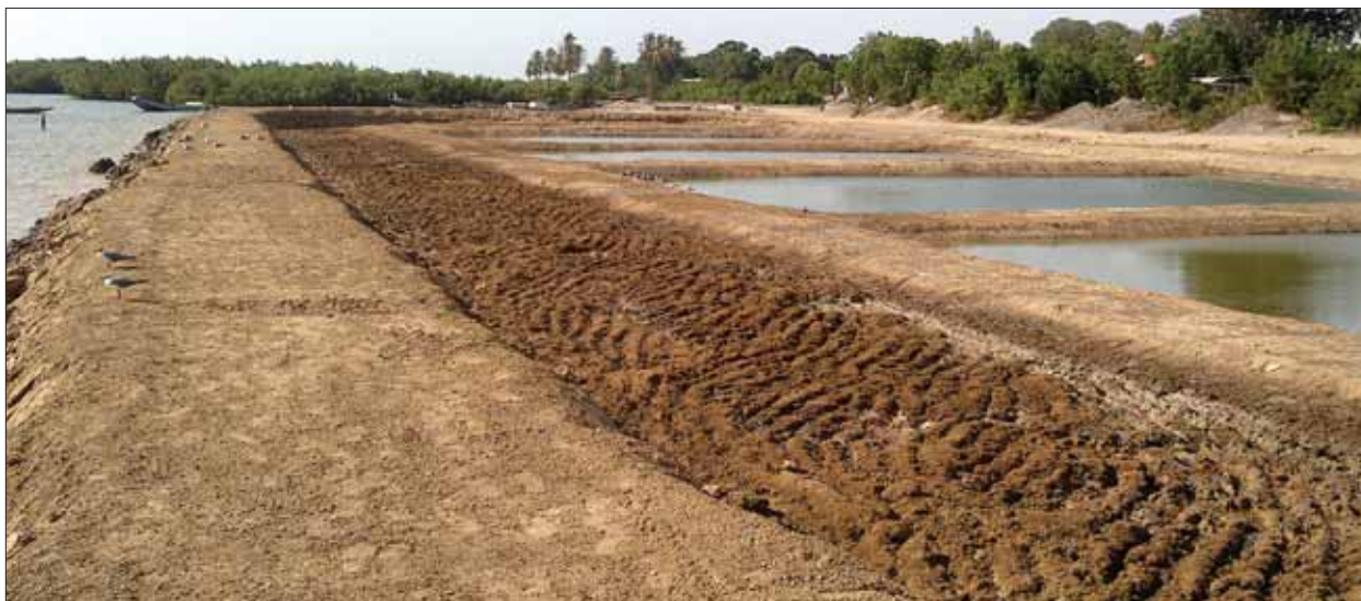
Photo 8 : Chantier de la ferme aquacole de Missirah, département de Foundiougne (CSE 2019 ; P2RS)
