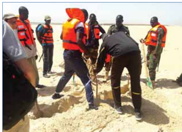
Photo 18 : Mise en place de typhavelles
