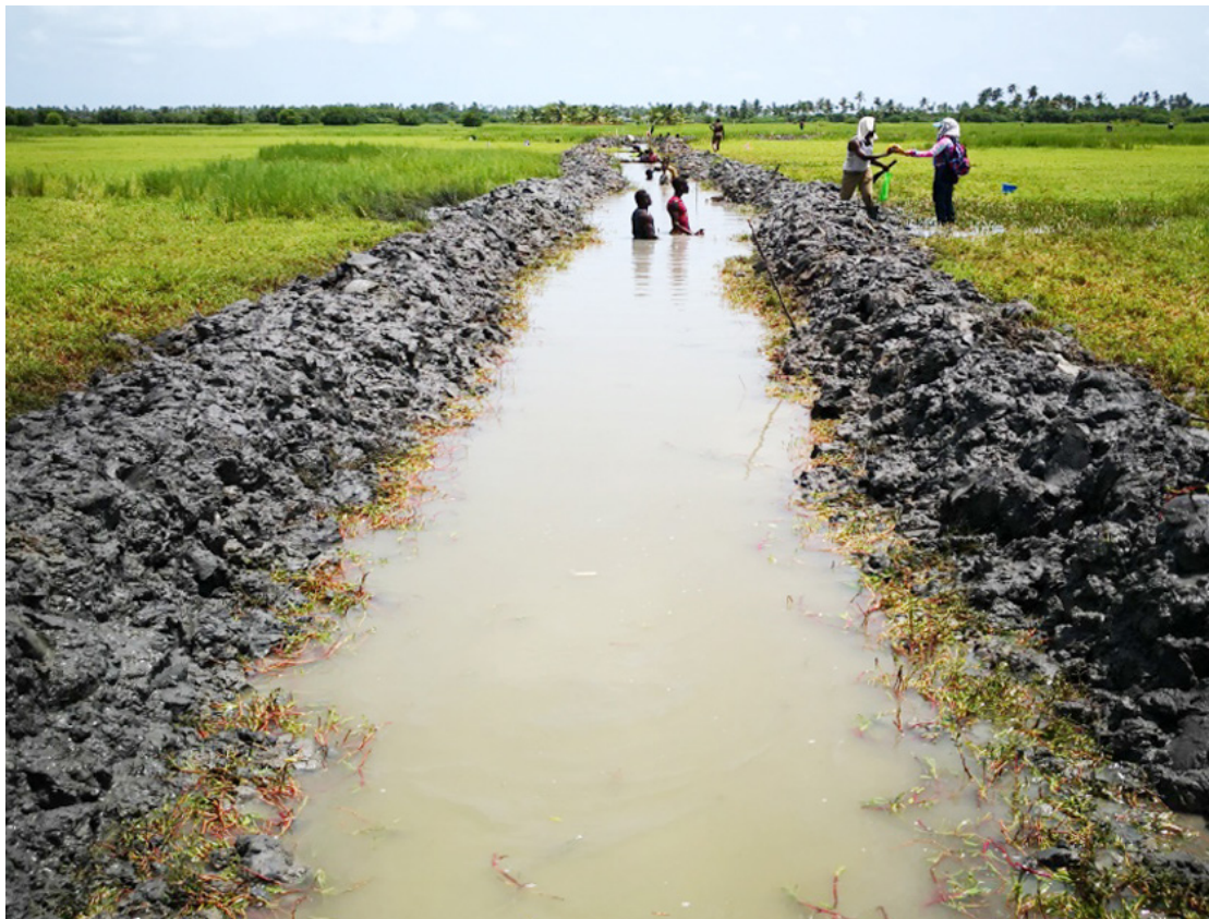
Photos 2 : Construction des canaux de régulation des paramètres physico chimiques
