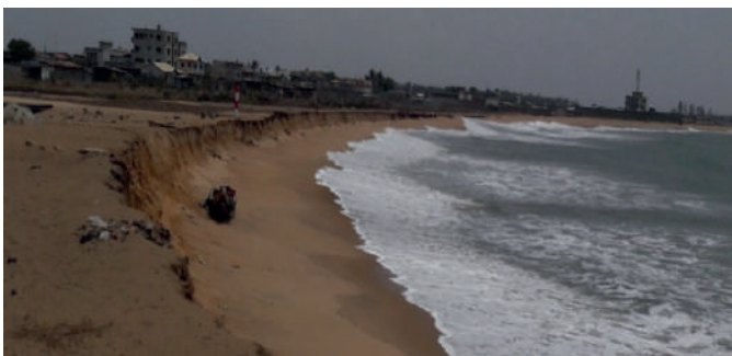
A) Avant les travaux : Situation de référence de la côte du segment transfrontalier à Hillacondji au Bénin
