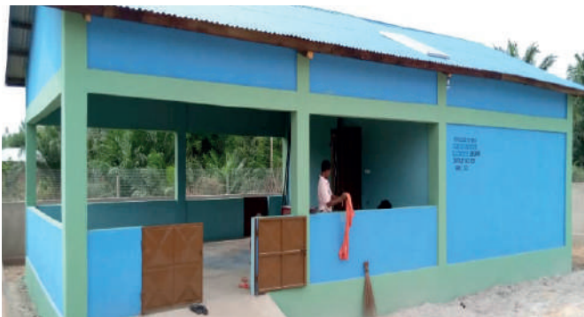
(I) Après les travaux en 2023
