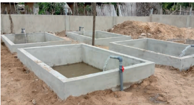
(I) Après les travaux en 2023
