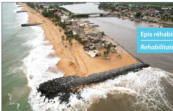
Brise lame réhabilité à Aného Rehabilitated breakwater in Aného
