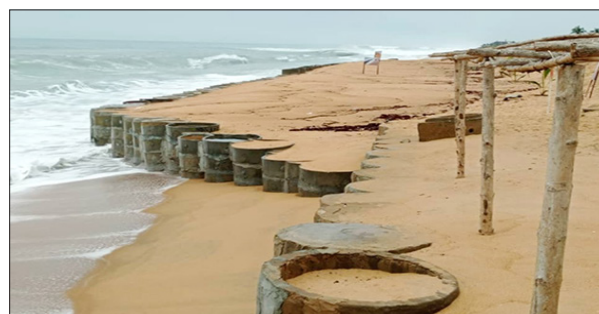
Buses de la protection côtière d'urgence à Gbodjomé
