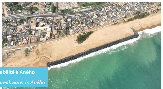
Epis réhabilités à Aného Rehabilitated groins in Aného
