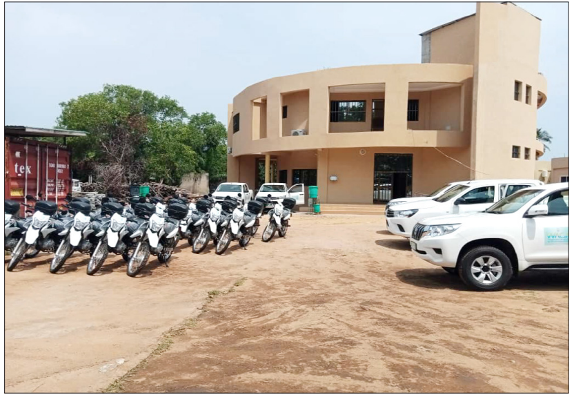
Bureau de l'UGP construit avec les véhicules et Motos acquis UGP office built with acquired vehicles and motorcycles
