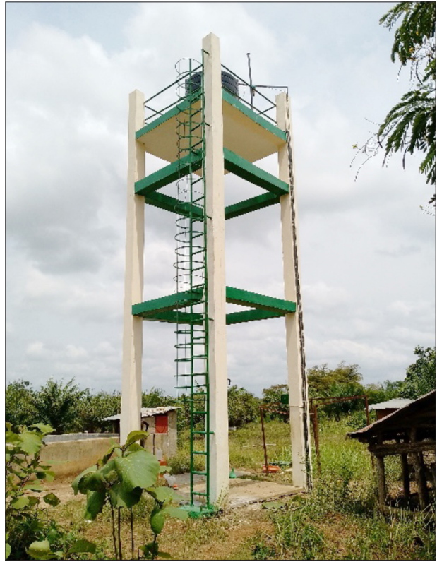
Forage installé à Kodjo Gag | Kodjo Gati borehole
