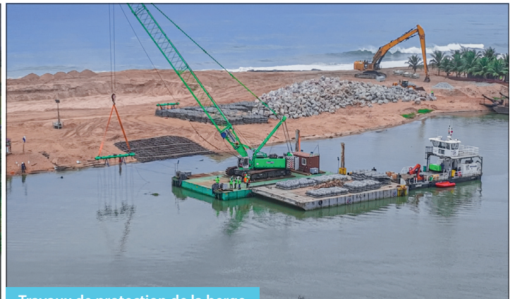
Travaux de protection de la berge Bank protection works
